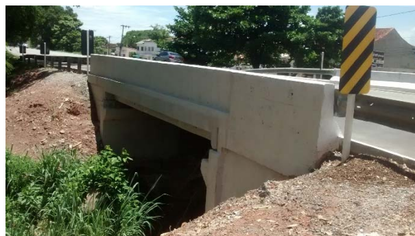
Figura 4 – Concluído o alargamento da ponte no local. Foto de: 23/01/2017.
