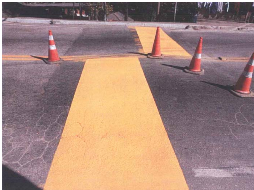
Foto 3 – Sinalização Horizontal - Km 41
