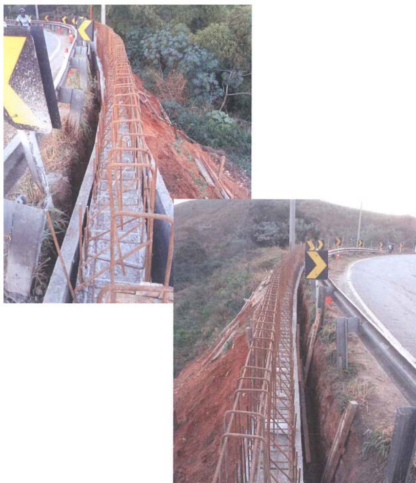
Foto 5 – Restauração de Dispositivo de Segurança - 132+500
