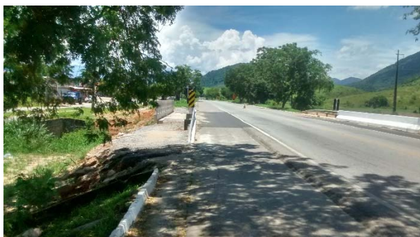
Figura 5 – Concluído o alargamento da ponte no local. Foto de: 23/01/2017.
