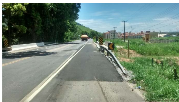
Figura 10 – Serviço de alargamento da ponte neste local. Foto de: 11/10/2016.
