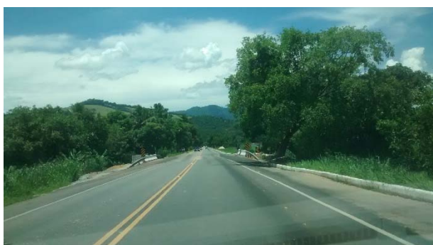
Figura 11 – Concluído o alargamento da ponte no local. Foto de: 23/01/2017.
