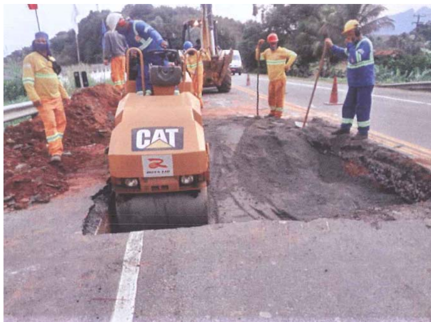
Foto 1 – Restauração do Pavimento - Km 32+500
