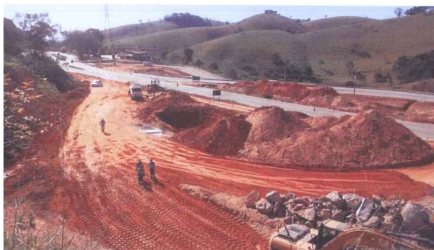
Foto 6 – Adequação da Interseção Cordeiro A - 123+300
