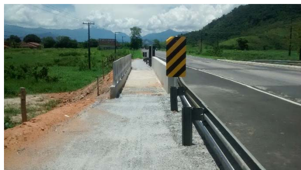
Figura 8 – Concluído o alargamento da ponte no local. Foto de 23/01/2017.
