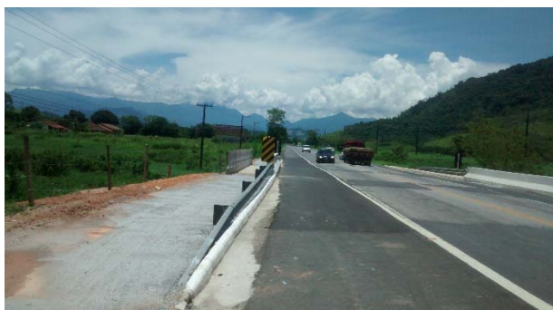
Figura 7 – Concluído o alargamento da ponte no local. Foto de 23/01/2017.
