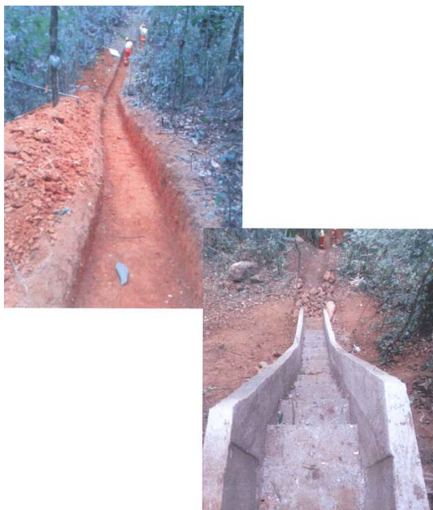
Foto 4 – Ampliação Drenagem - Km 48,8
