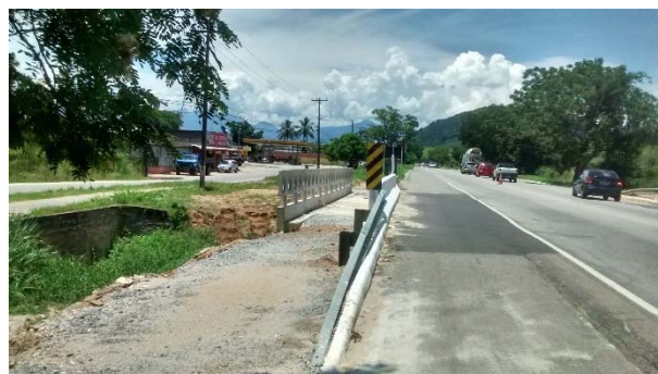
Figura 6 – Concluído o alargamento da ponte no local. Foto de: 23/01/2017.
