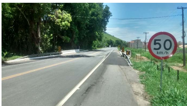
Figura 9 – Concluído o alargamento da ponte no local. Foto de: 23/01/2017.
