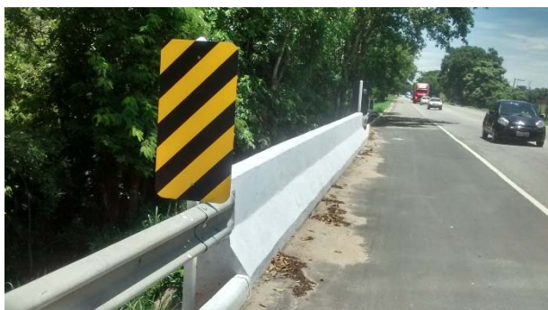
Figura 3 – Concluído o alargamento da ponte no local. Foto de: 23/01/2017.
