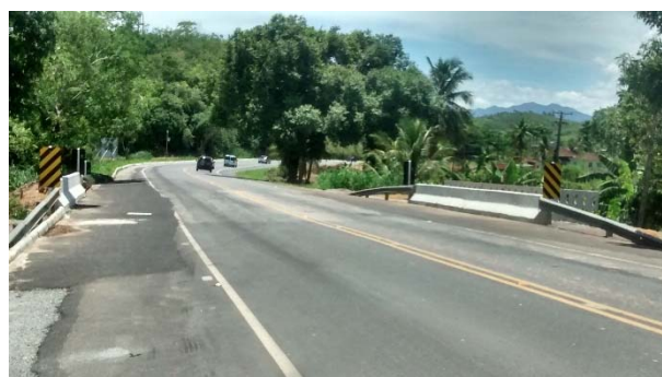
Figura 12 – Concluído o alargamento da ponte no local. Foto de: 23/01/2017.
